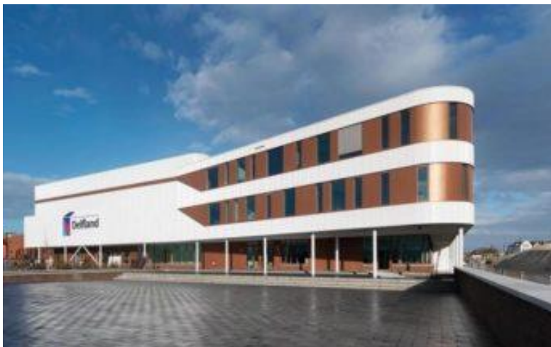
Scholencombinatie Delfland o Realisatie dec. 2022 o 202 panelen van 385 Wp o 69.000 kWh per jaar
