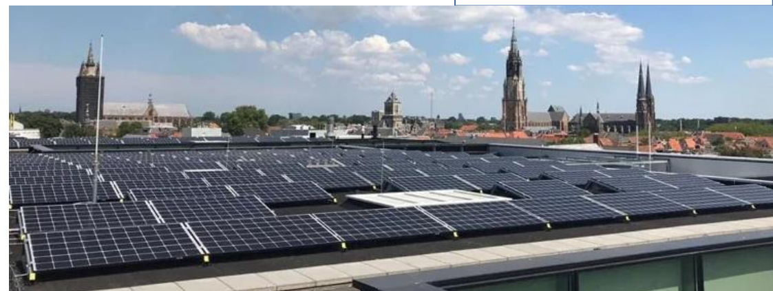
Stadskantoor Delft o Realisatie juni 2018 o 304 panelen van 300 Wp o 88.000 kWh per jaar
